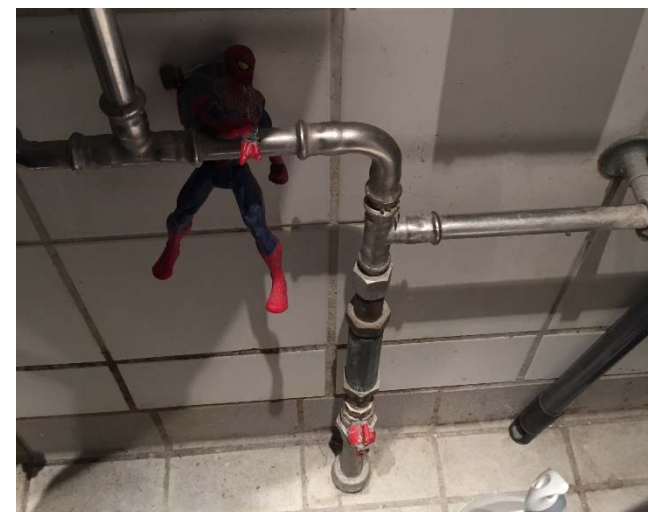
Sammenblanding af flere forskellige typer rør og materialer.
