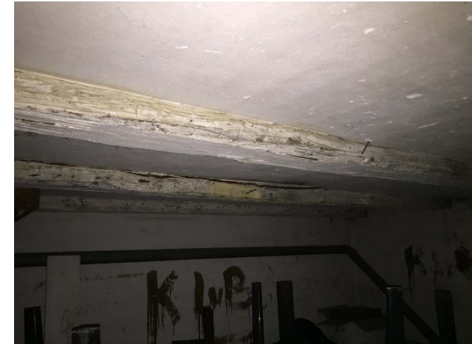
Etageadskillelse i kælder fremstår generelt intakt.
