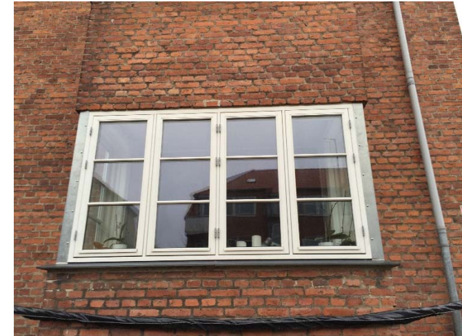
Der er nyere trævinduer på hele ejendommen.
