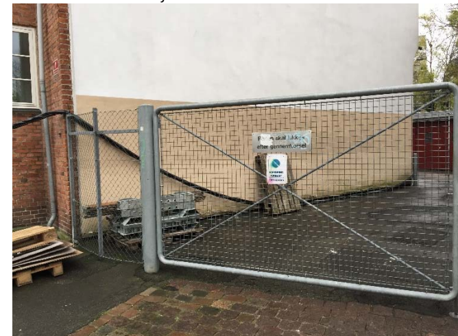
Port ved Tustrupvej.
