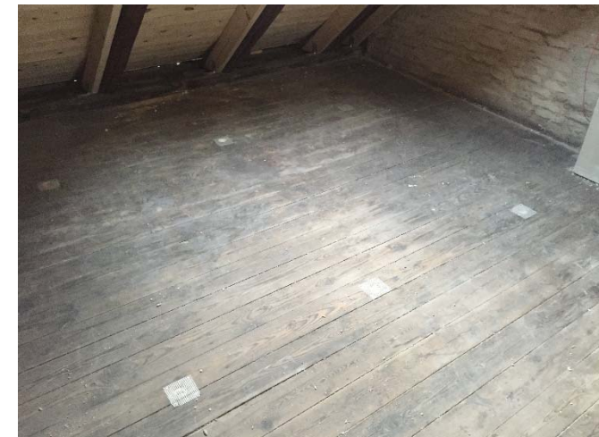
Etageadskillelse mod loftrum er efterisoleret ved indblæsning af mineraluld.
