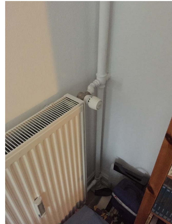
Radiatoranlægget er udført som et 1-strengt anlæg.
